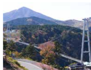
九重夢吊り大橋
